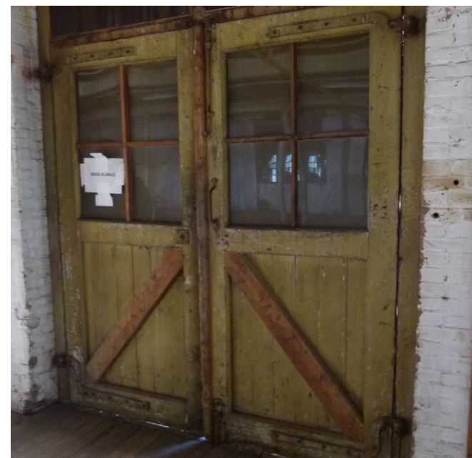
houten kozijnen en laaddeuren
