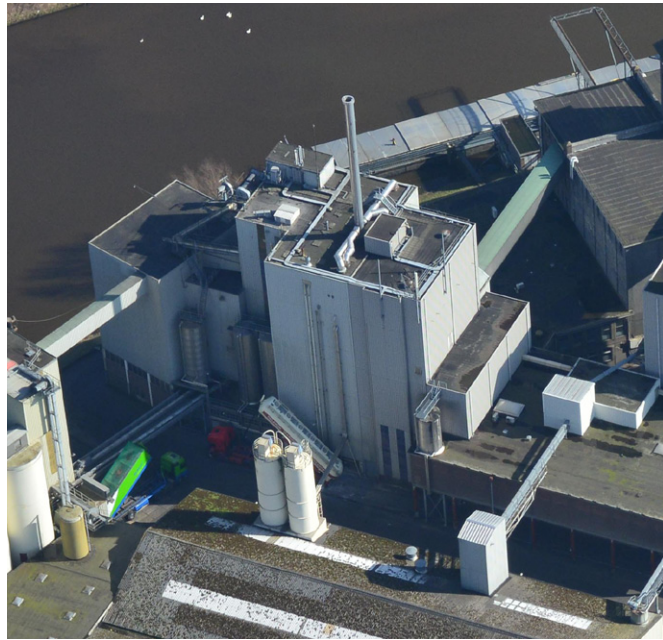
meeldoseerinstallatie, perserij en schrootsilo gebouwd op veevoederfabriek
