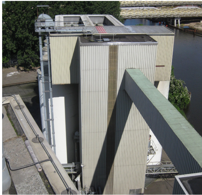
silobouw met transportbrug
