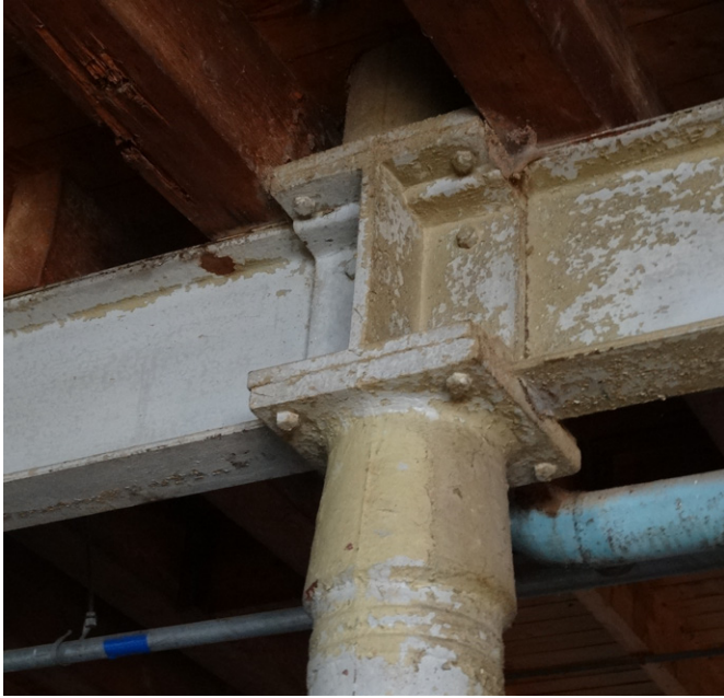
gietijzeren kolom
