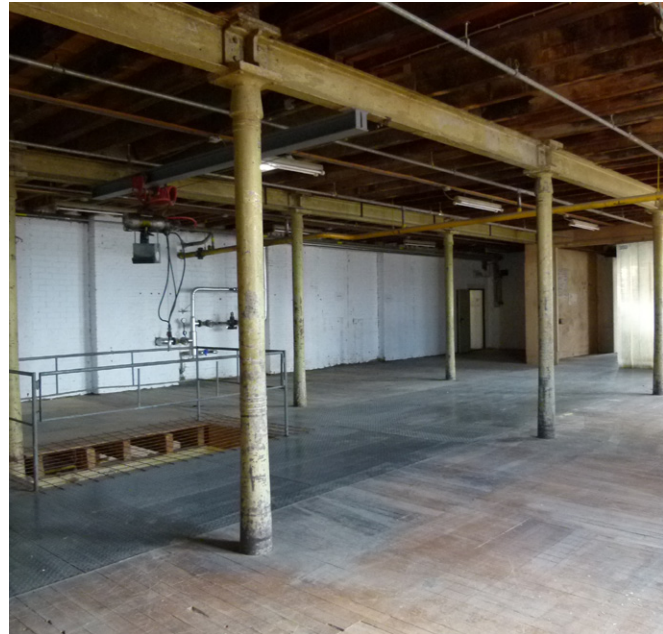
constructie met gietijzeren kolommen, ijzeren onderslagbalken en houten balkenvloer
