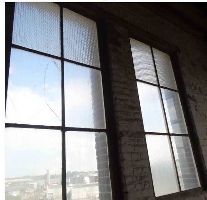
gewalste ijzeren ramen met draadglas op de zolderverdieping
